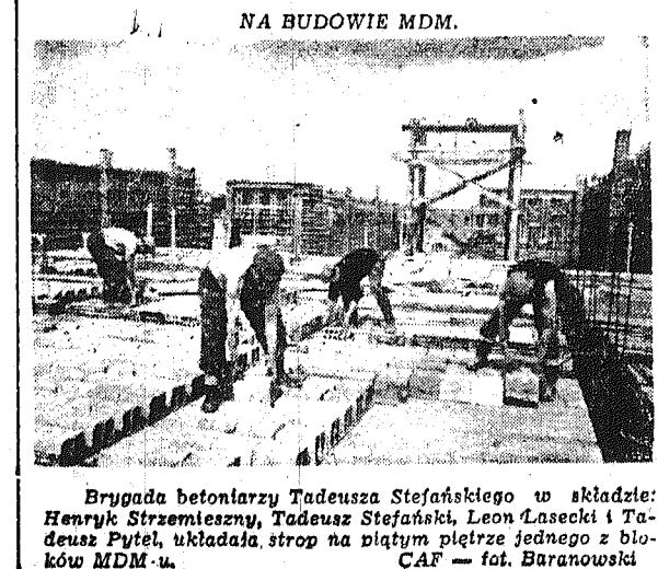
Brygada betoniarzy Tadeusza Stefańskiego w składzie: Henryk Strzemielny, Tadeusz Stefański, Leon Łasecki i Tadeusz Pytel, układała strop na piątym piętrze jednego z bloków MDM-u. CAF — fot. Baranowski
