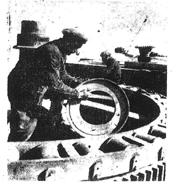
Na zdjęciu: Montowanie koparki, dostarczonej drogą rzeczna — w porcie Tachia - Tasz. Na pierwszym planie brygadier Safulita Maipow. Fot — CAF
