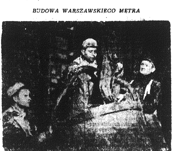
Roboty przy budowie warszawskiego Metra postępują w szybkim tempie naprzód. W szeregu szybów ślący górnicy prowadzą intensywną pracę przy drążeniu tzw. „korystarzy”...
