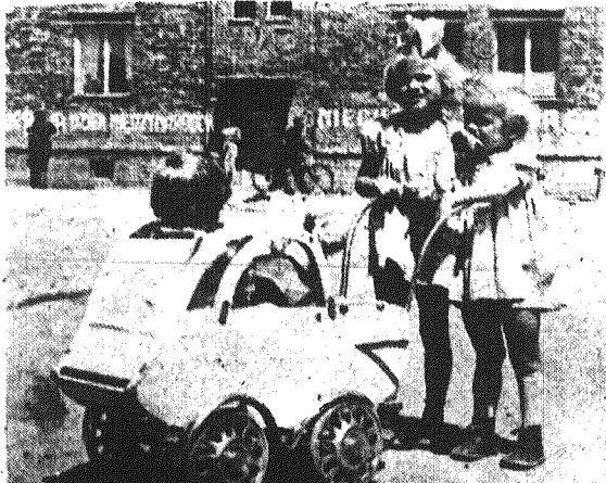
Murarski front pracy zdobywa teren, pozostawiając poza sobą bloki, ścianki, ulice, dziedanki i place, na których dzieci mieszkanców osiedla gępczyną swą młodzież. Zdjęcia A. Sandach.
