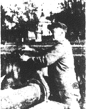
Maszynista wodociągów i kanalizacji, Lucjan Wijas odkręca zawór przy rurze ssącej. Za chwilę woda ze stawu znacznie przepływać rurami do Silnicy.
