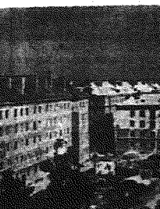
Z opłonej Herby 6.750 nowych łąk, które mają być w h.r. oddane ludzkom pracy woj gdańskiego, przekazano już w ciągu 3 miesięcy 3.320 łąk. Ostatnio budowniczości osiedla dla stoczniowców w Gdańsku zdobili do użytku dalsze nowoosbudowane bloki mieszkaniowe przy ulicy Karłowickiej. Na zdjęciu: Pasażerka nowoosbudowanego się osiedla dla stoczniowców.
