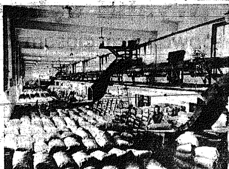
Kombinat chemiczny im. Stalina w Dymitrowgradzie jest największym tego rodzaju obiektem przemysłowym na półwyspie bałkańskim. Kombinat nie tylko zaspokaja zapotrzebowanie rolnictwa bułgarskiego, lecz zaspokaja w nowożytnie równie Grecji i Rumunii. W niedługim czasie Bułgaria eksportować będzie produkcję kombinatu do Chin, Czechosłowacji, Anglii, Holandii i innych krajów. Na zdjęciu: magazyn saletry amoniakalnej w kombinacie chemicznym im. Stalina. Fot — CAF
