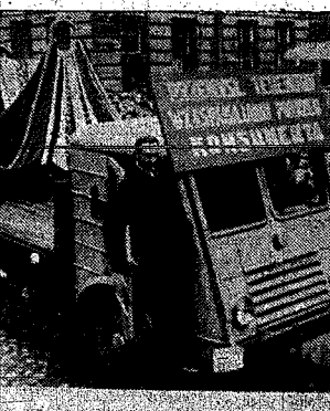
Idą budowniczości z kieleckiego ZBM.
