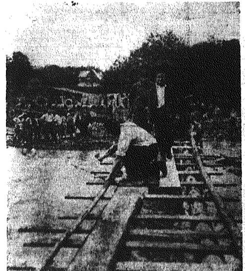
Na miejscu zerwanego mostu w Poroninie zbudowano prowizoryczną kładkę. Fot. CAP
