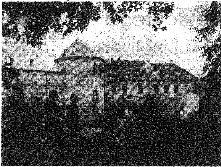
Piękny zamek w Lesku (woj. rzeszowski), dawna posiadłość Krasickich, służyć będzie obecnie jako dom wczasowy dla górników kopalni „Kopalnia” w Zabru. Na generalny remont tego obiektu — Rada Robotnicza oraz dyrekcja kopalni przysłała 700 tysięcy zł. Prace remontowe rozpoczęły w kwietniu br. Zakonieczanie ich przewidziano jest w przyszłym roku. W Lesku odpooczywać będzie ponad 600 górników rocznie. A tymczasem — w nadającej się do zamieszkania części zamku zorganizowane zostaną kolonie dla dzieci górników. CAF — fot. Kublak
