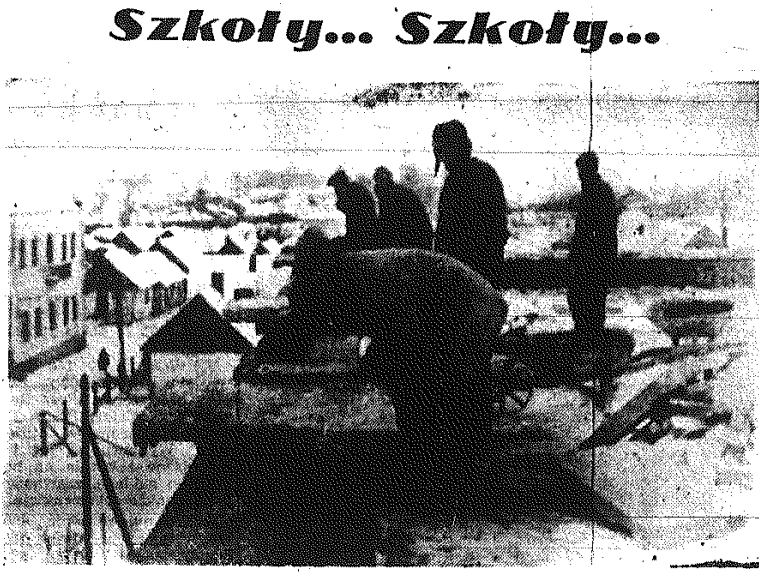
Mimo simy ludzie pracują przy budowie. Nie dziwnego: szkoła w RADOSZYCACH (pow. Końskie) jest bardzo potrzebna.
