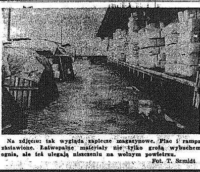
Na zdjęciu: tak wygląda miejsce nagłego „Piało” rampa zastawiona. Łatwopalne materiały nie tylko grozą wybuchem ognia, ale też ulegają niszczeniu na wolnym powietrzu.
