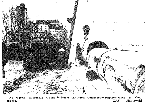
Na zdjęciu: układanie rut na budowie Zakładów Celulozowo-Papierniczych w Kwidzynie. W tle: Uklejowski
