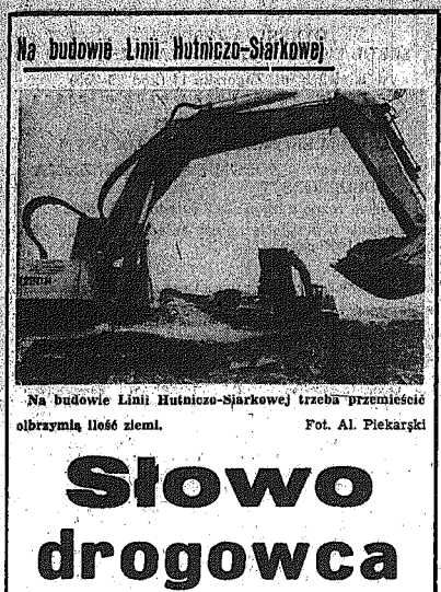
Na budowie Lini Hutniczo-Sparkowej trzeba „pniekować” obryzania linii ziemi. Fot. Al. Piekarczyk
