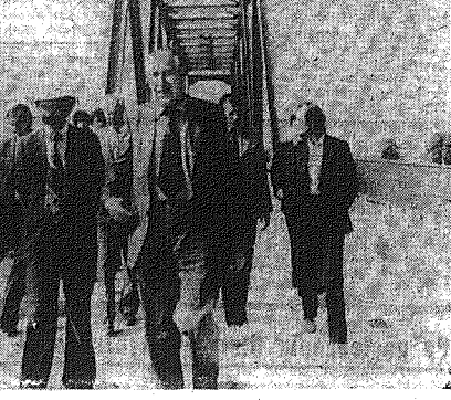
Pełnomocnik rządu do spraw budowy LHS, wiceminister komunikacji Kazimierz Jaenkowicz (na pierwszym planie) w towarzystwie głównego inżyniera GKB Przedsiębiorstwa Robot Kolejowych nr 15 we Wrocławiu Tadeusza Alberskiego i budowniczych LHS ogląda przekazane wczoraj obiekty inżynierskie.
