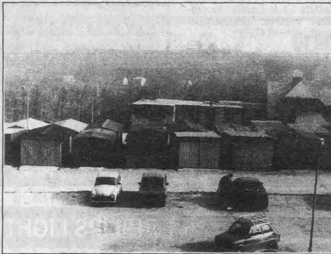
„Blaszaki” w osiedlu Gen. Sikorskiego w Miechowie. Czy znikną?
