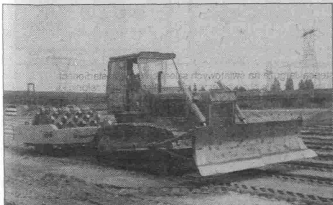
Zakład Transportu Energetyki posiada sprzęt do robót budowlanych i ziemnych.
