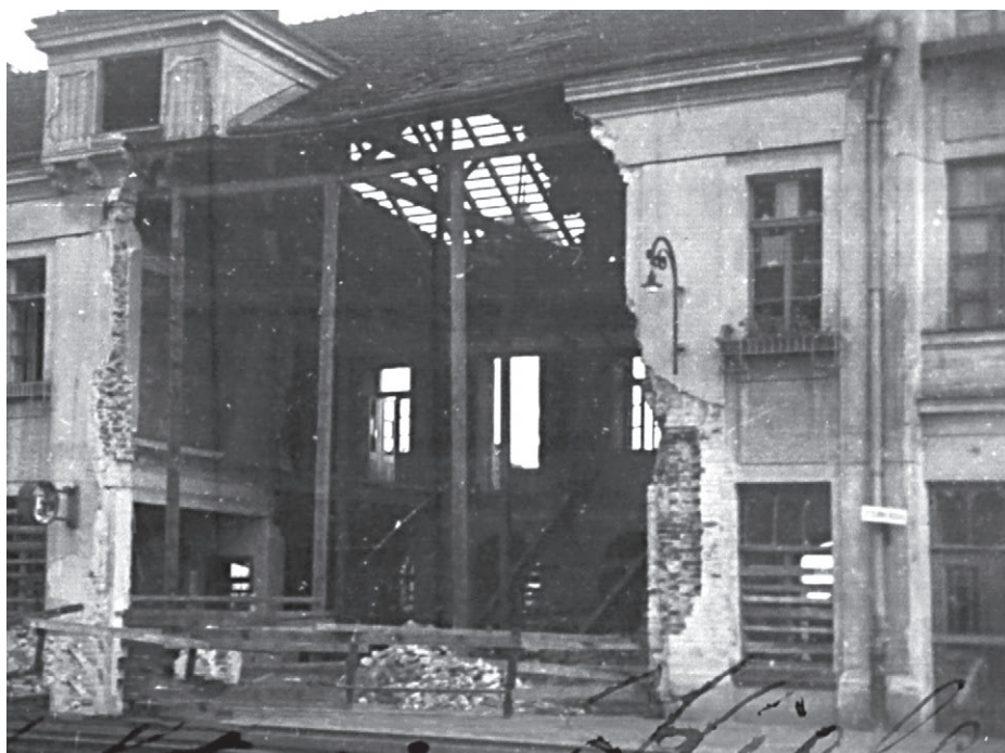
Dworzec w Kielcach od strony peronów po niemieckim bombardowaniu we wrześniu 1939 r. Fot. ze zb. MHK.
