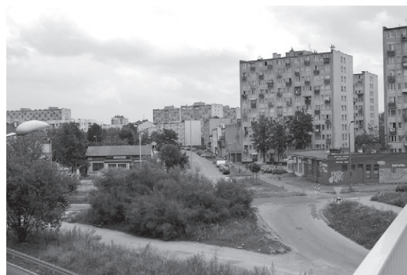
Ul. Chęcińska, widok w kierunku miasta. Tędy wycofywali się obrońcy Kadzielni. Fot. autor.
