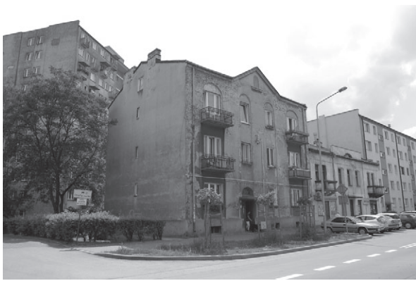
Kamienica przy ul. Chęcińskiej 11, w której ukrył się ptk. Wilniewicz. Fot. autor.
