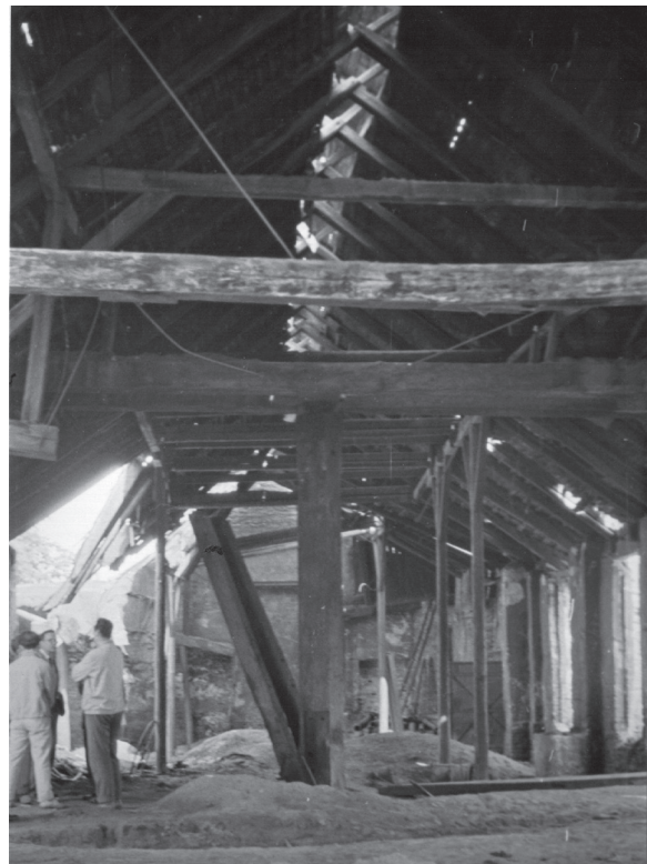
Odlewnia żelaza (walcownia).
