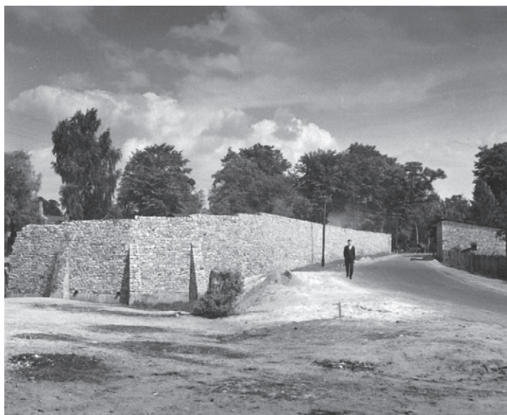
Zakład przemysłowy – ulica Za Walcownią.
