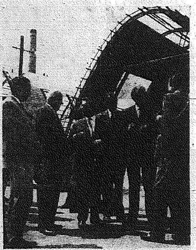
Na budowie huty szkła w Sandomierzu. Tow. Zambrowski kierował informacją u dyrektora zakładu - Wacława Brzozowskiego.
