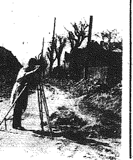
Rozpoczęło przebudowę ulicy Mielecarskiego na odcinku od ulicy Karłowickiej do Krakowskiej...
