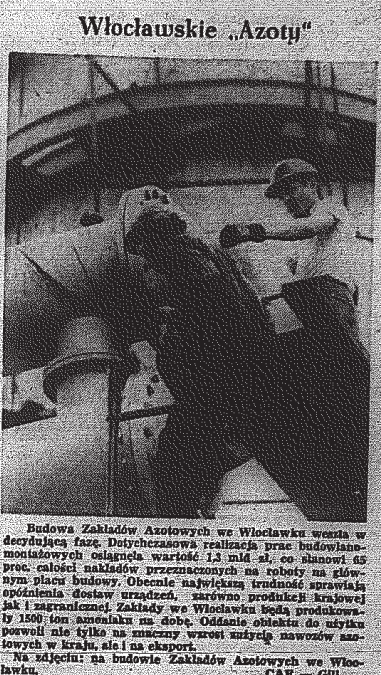
Budowa Zakładów Azotowych we Włocławku w czasie budowy...
