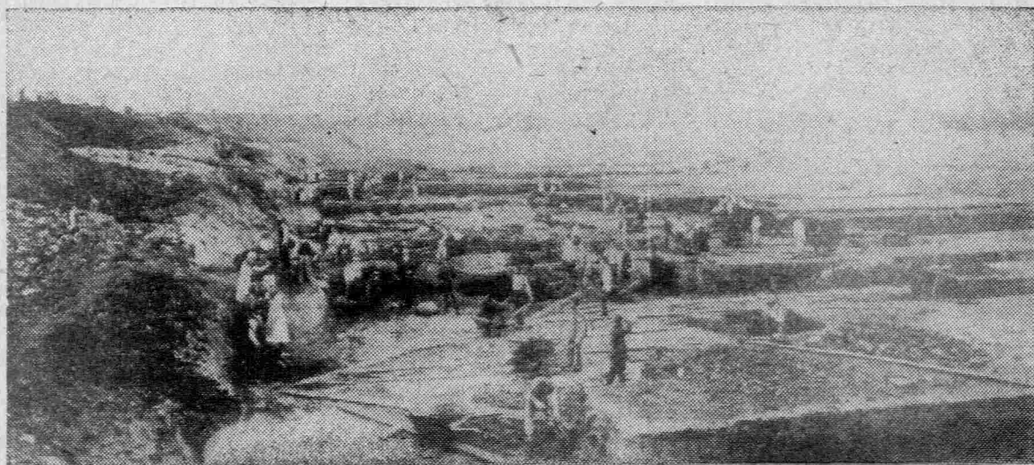
Kopalnia odkrywkowa rudy
