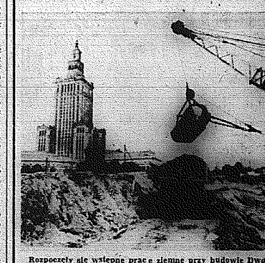
Rozpoczęły się roboty przy budowie Dworca Centralnego w Warszawie.
