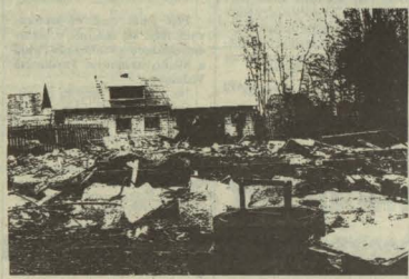
Wnętrze zniszczonego budynku w Lisowie. Wybuch zniszczył budynek w całości. Widać fragmenty muru i polowane belki.
