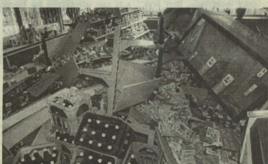
Zniszczone wnętrza sklepu spożywczego
