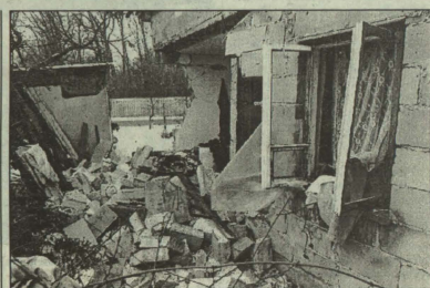
Domek nadaje się do rozbiórki
