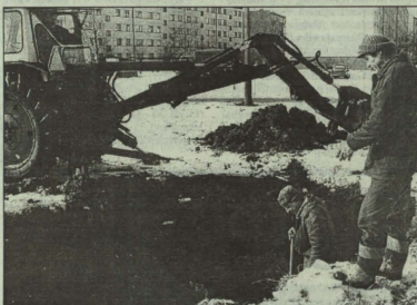
Końskie. Ekipa remontowa szuka usterek w rurach wodociągowych Fot. M. Kłusek
