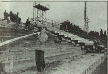
Na stadionie Łódzkiego Widzewa trwają ostatnie prace remontowe. Fot. PAP/CAF
