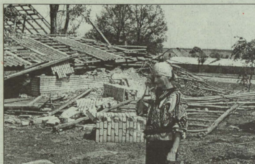
Takie zniszczenie spowodowała trąba powietrzna w gminie Gnojno Fot. D. Gacek
