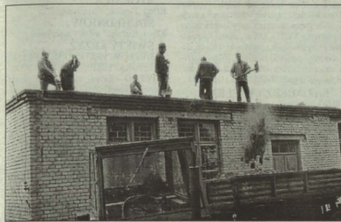
Trwa remont szkoły w Krajówce
