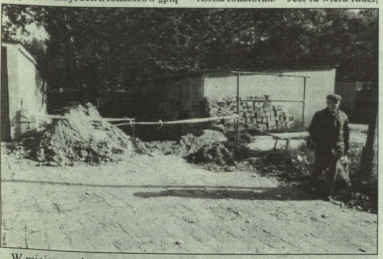
W miejscu wyburzonego śmietnika powstaje garaż
