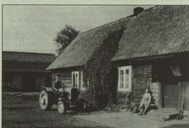
Zabudowania Strażów z Lipnicy grożą zawaleniem, a na budowę nowych nie ma pozwolenia
