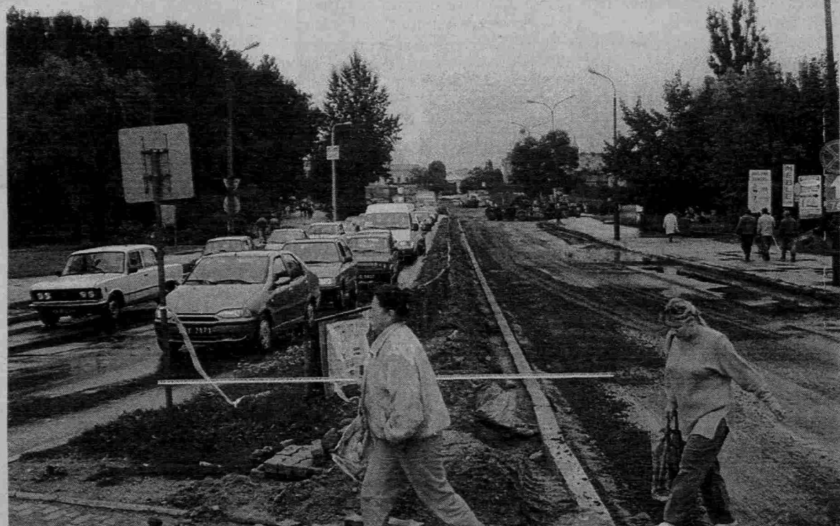
Miasto sparaliżowane remontami jezdni
