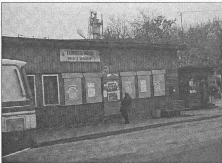
Już wkrótce drewniany barak przestanie straszyć podróżnych
