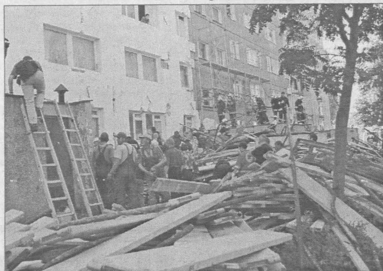
Miejsce katastrofy budowlanej na osiedlu Zaspa w Gdańsku
