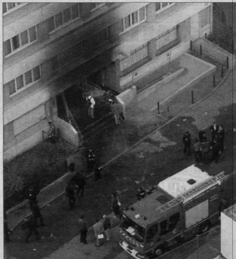
Wieżowiec mieszkalny w mieście L'Hay-les-Roses po pożarze, który wybuchł w nocy z soboty na niedzielę
