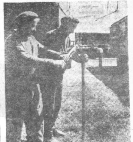
Pracownicy WPKM podczas zakładania instalacji wodociągowej. Fot. Al. Piekarski
