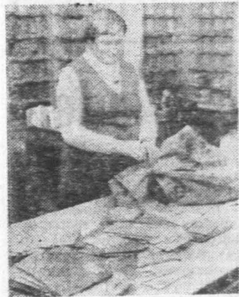
Anna Jarzab przy pracy w rozdzielni — miasto.
