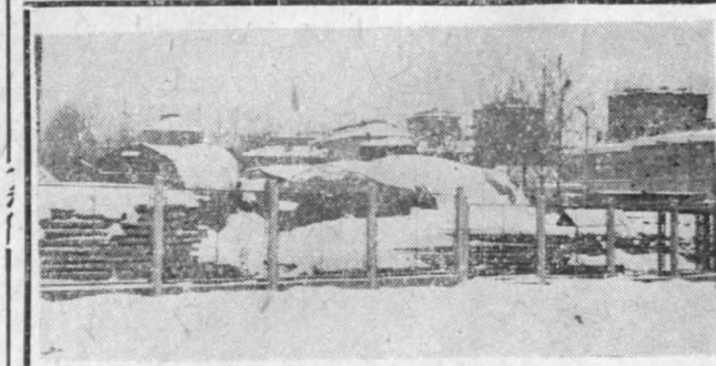
Obfite opady śnieżne spowodowały uszkodzenie magazynu pneumatycznego.
