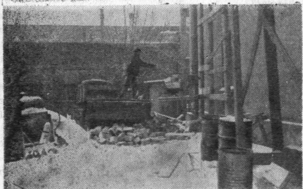
Budynek księgowości powiększył się o jeszcze jedną kondygnację. Na zdjęciu: transport cegły na II piętro.
