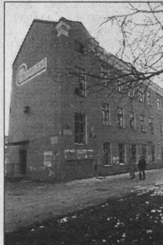
Budynek po „Geoprojekcie”.
