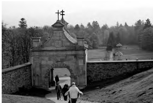
Końcowy odcinek Drogi Królewskiej od Nowej Słupi do Św. Krzyża. Fot Jerzy Osiecki
