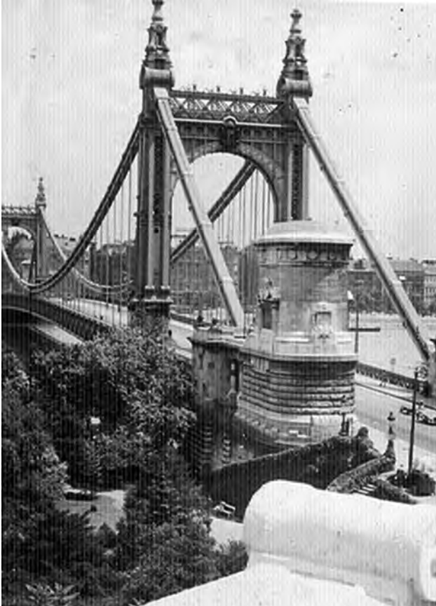
Most Elżbiety – zbudowany w latach 1897–1903 do 1927 r. stanowił sensację techniczną, jako jedyny most łańcuchowy na świecie o przeszle łączącym brzegi rzeki odległe aż 290 m
