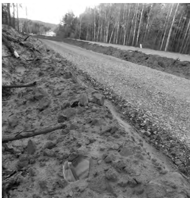
Fragment obudowy Glasmine na poboczu przebudowywanej drogi wojewódzkiej nr 764 (Kielce – Staszów) w Łukawie (wiosna 2019 r.).
