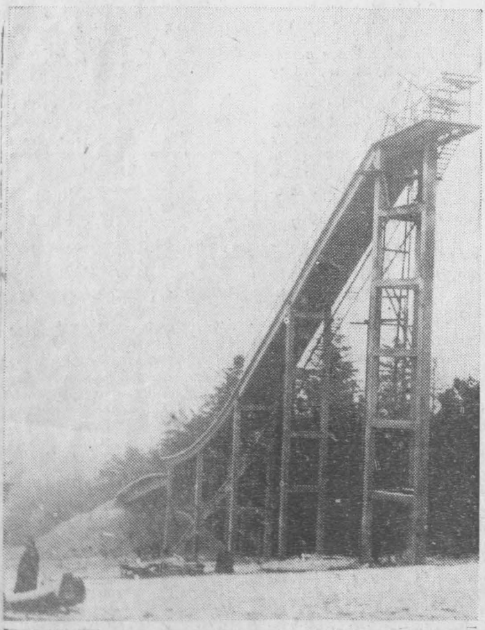
Skocznia narciarska w Kielcach
