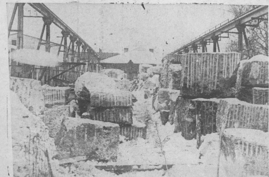
Kieleckie Zakłady Kamienia Budowlanego
