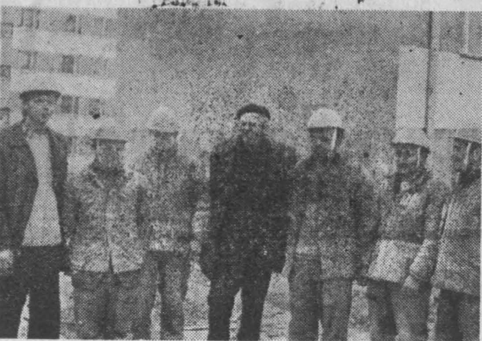
Na zdjęciu: Brygada montażowa BPB realizująca powierzone jej zadania na budowie osiedla mieszkaniowego Skarpa II. Od lewej: Zbigniew Sawicki (brygadysta), Zdzisław Dywan, Czesław Cwik, Wiesław Dytkowski (kier. budowy), Paweł Kwiecień, Mieczysław Szumilas i Stefan Sikora.
