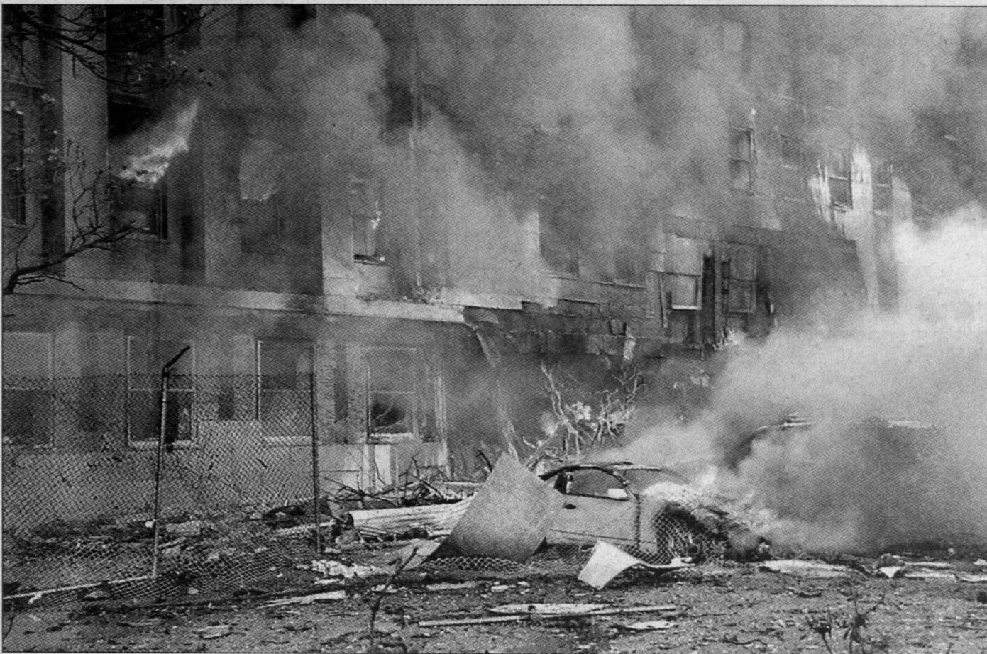
Pożar Pentagonu po ataku terrorystycznym, gdy na budynek spadł samolot.
