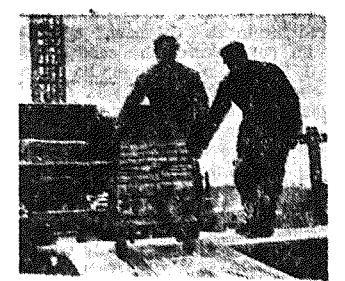
Na MDM odbyła się próba zorganizowania dostaw materiałowych na budowę przy pomocy kontajnerów, tj. klatek metalowych wykonanych z odpadków żelaza budowlanego.
