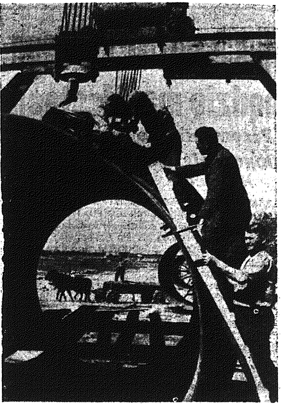
W Wierzbicy koło Radomia powstaje nowoczesna cementownia. Projekty budowy hal sporządzają nasi inżynierowie przy pomocy inżynierów leningradzkich. Maszyn dostarcza Związek Radziecki. Na zdjęciu: Brygada Stalowa Maselki przy montażu pierścienia obrotowego pieca.
