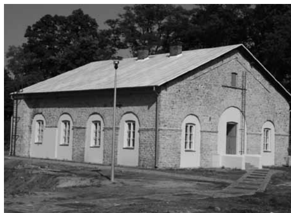
Maszynownia, stan obecny. Fot. Magdalena Gorzkowska
