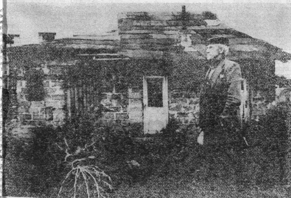
Częstochowskie budownictwo mieszkaniowe — dom przy ul. R. Luksemburg.
