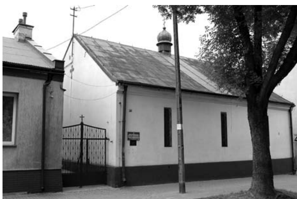
Cerkiew przy ul. Bodzentyńskiej 46.
