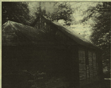
Kaplica od strony prezbiterium
